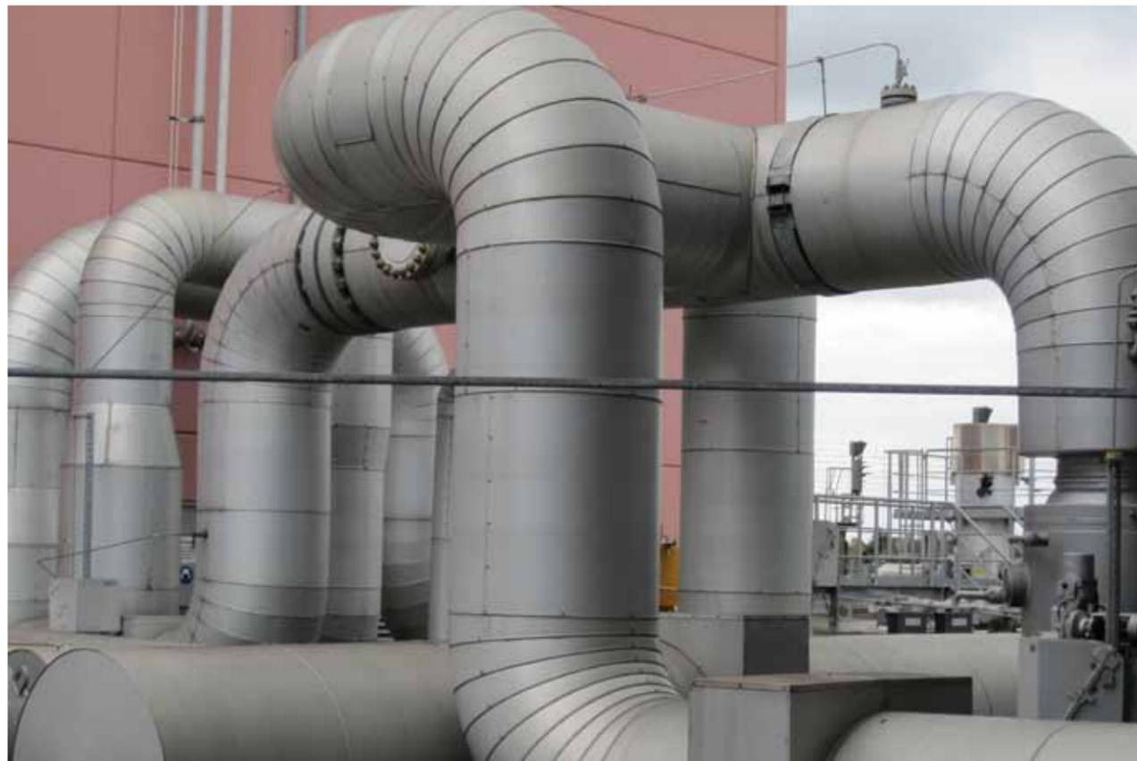
Abb. 1: Rohre für den Gastransport innerhalb einer Verdichterstation. Foto: Prof. Alexander Martin
